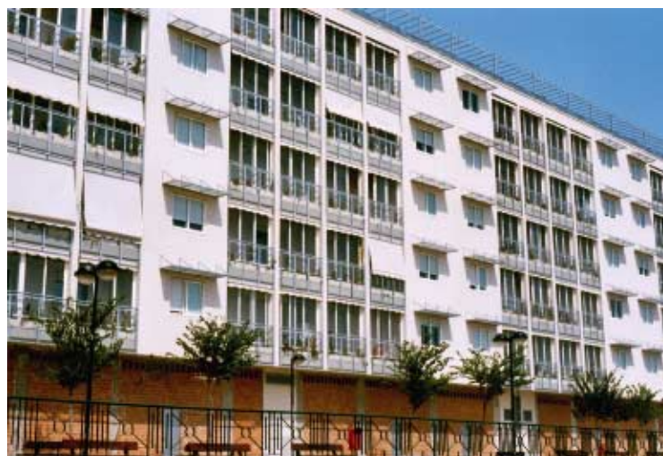
Edificio Parque Goya Fundación Ecología y Desarrollo.
